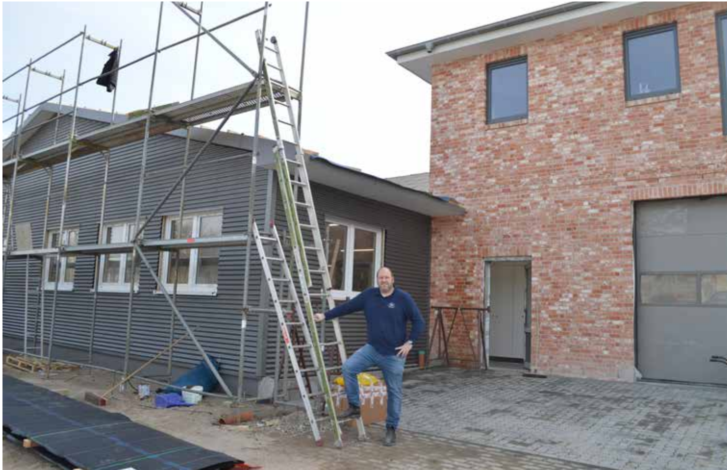
Marcus Ranck-Wellingerhoff vor dem Neubau (re.) und dem alten Gebäude, das eine neue Fassade und ein neues Dach bekam.
