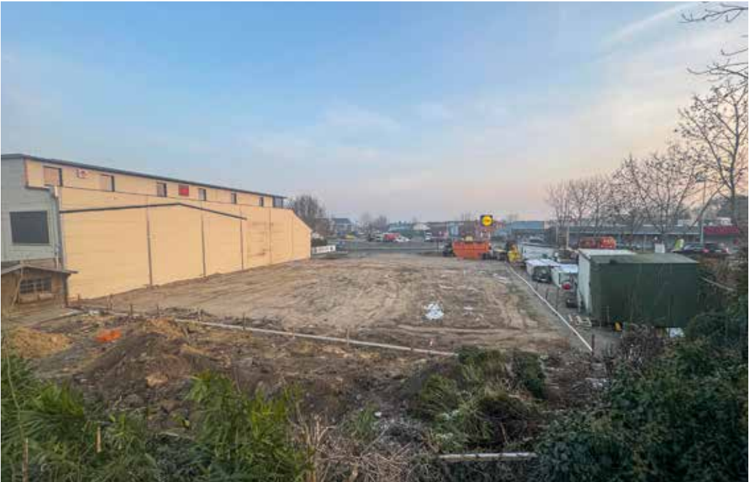
Dort, wo im Wyker Gewerbegebiet »Föhr Bike" zu finden war, sind die Abbrucharbeiten beendet.
