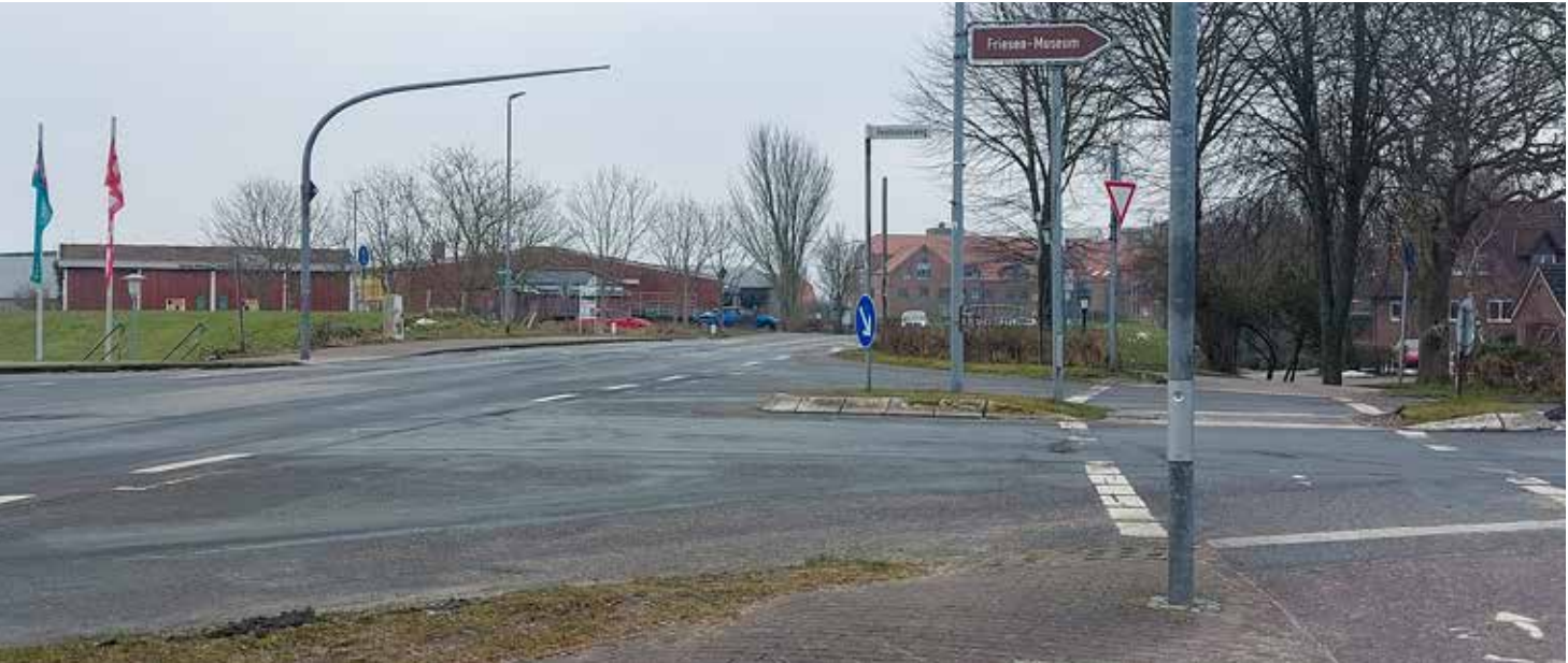
An der L214, Bereich Heymannsweg und Koogskuhl, soll bis Ende Juni 2026 ein neuer, dritter Kreisverkehr gebaut werden Foto: Andreas Hansen AmtFA
